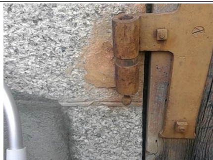
Photo n° PhA009 Localisation : Rez de chaussée écurie - Garage Ouvrage : 2 - Parois verticales extérieures et Façades - Façades lourdes y compris poteaux Partie d'ouvrage : Ragréage Description : Ragréage Scellement
